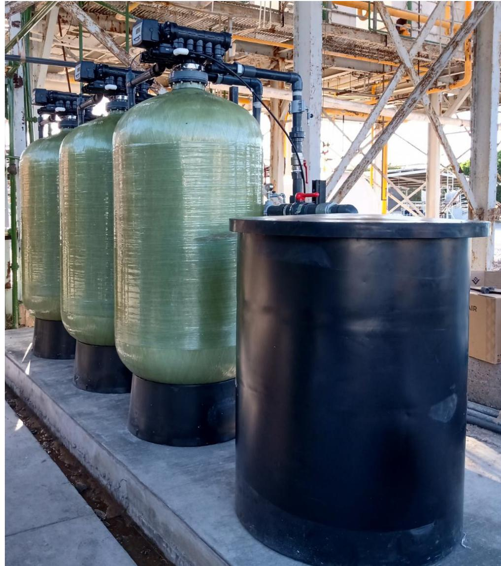
Equipos de Suavización diseñados por SYPYSA
